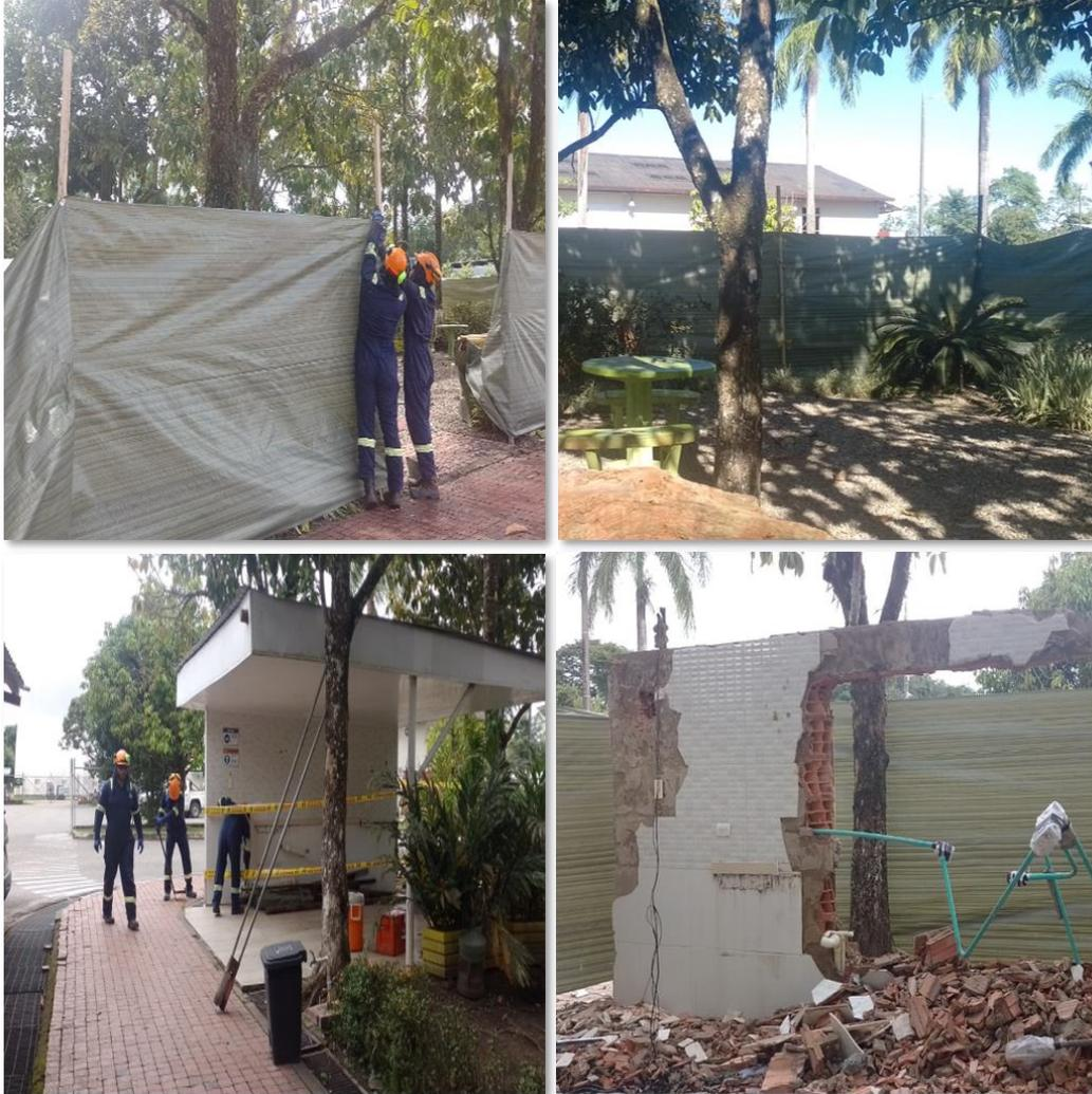
**Nota.** Acompañamiento al proyecto ampliación de cafetería, Deck Eco cafe, registró fotográfico, cerramiento del área a intervenir y demolición de cafetería existente, los compañeros de trabajo utilizando los elementos de protección personal y delimitando área con cinta de peligro.
