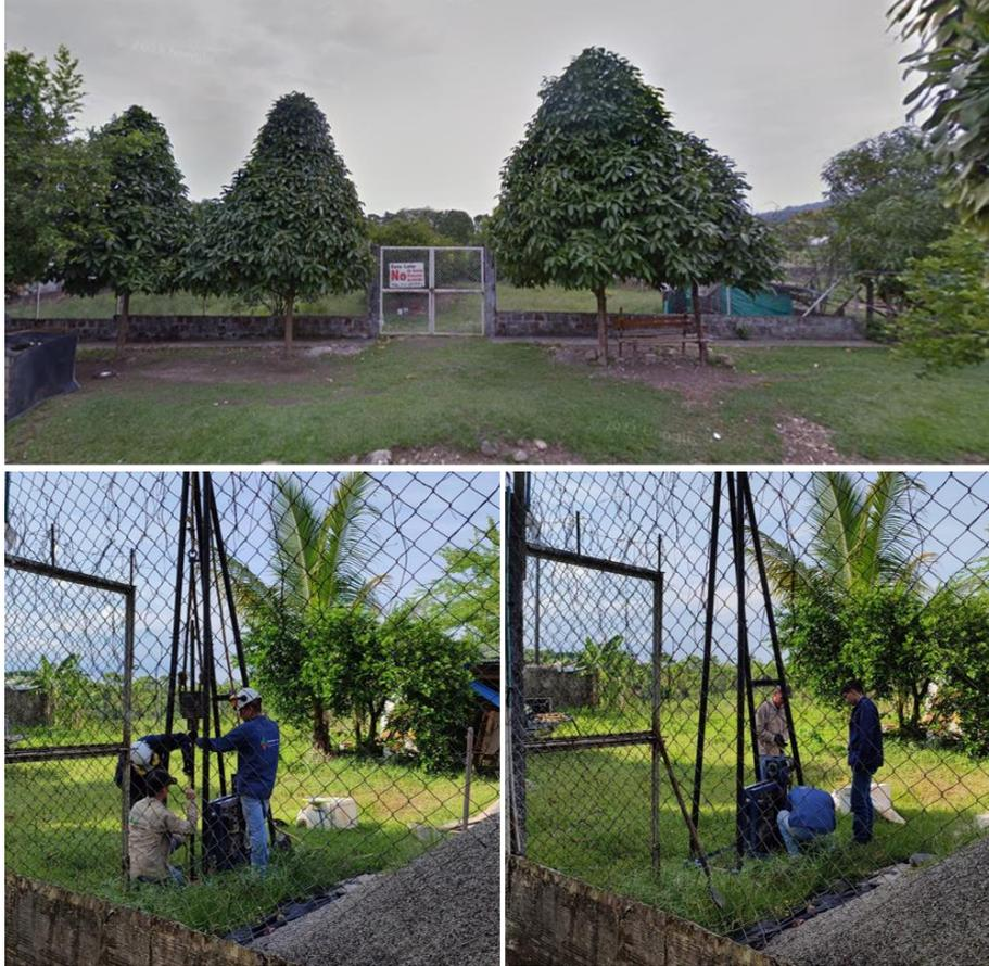
**Nota.** Se llevó a cabo un proceso de acompañamiento al lote ubicado en el barrio Montecarlo, el cual comprendió un levantamiento detallado del entorno y del propio terreno. Durante este procedimiento, se ejecutó una toma de usos del suelo mediante la realización de dos apiques.
