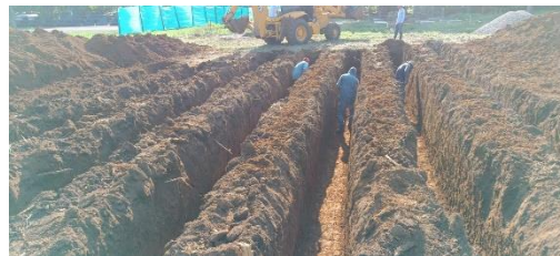
Ilustración 19 Zanjas de filtración
