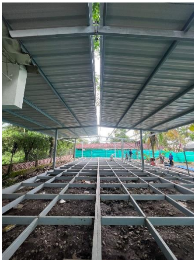
Ilustración 21 Izaje estructura metálica
