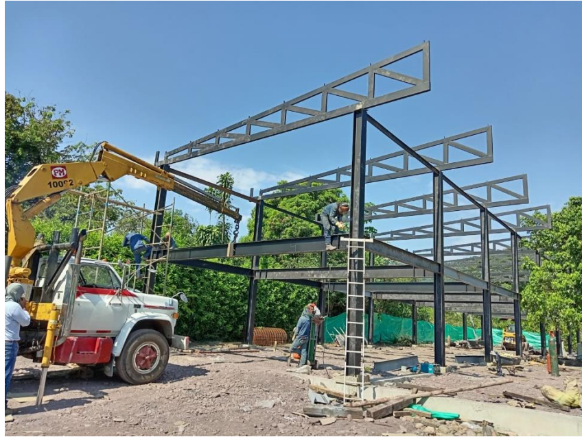
Ilustración 30 instalación de estructura metálica
