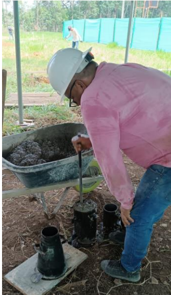
Ilustración 16 Ensayo prueba de concreto
