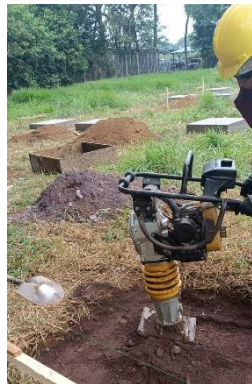
Ilustración 18 Mejoramiento cimentación
