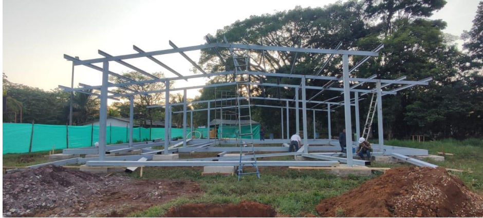
Ilustración 24 Izaje estructura metálica
