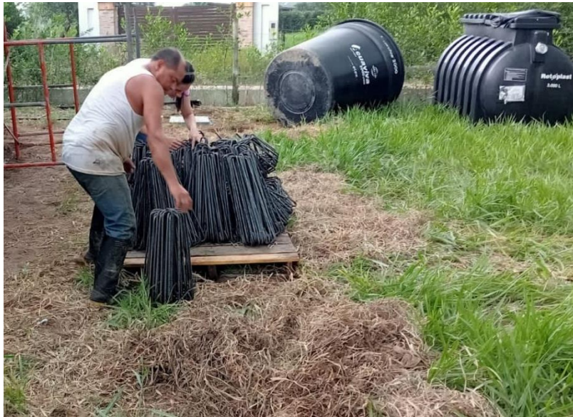
Ilustración 25 inicio de la obra
