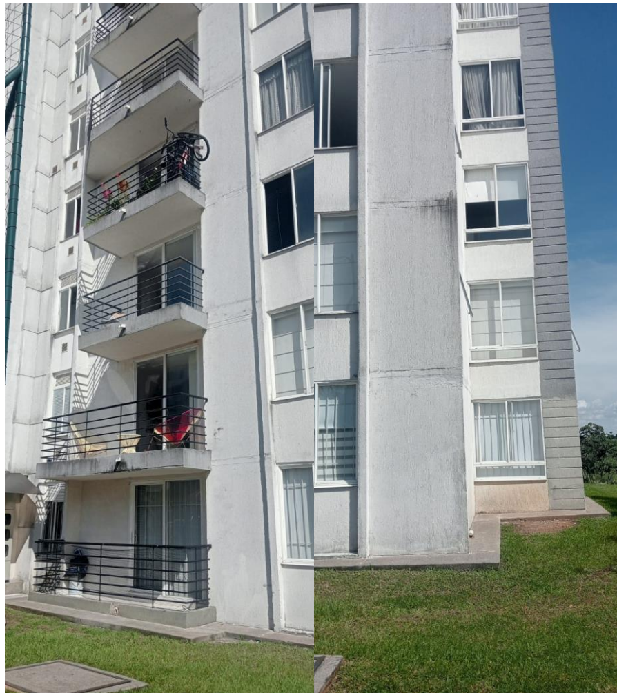
Figura 60 Conjunto Torres de la pradera.
