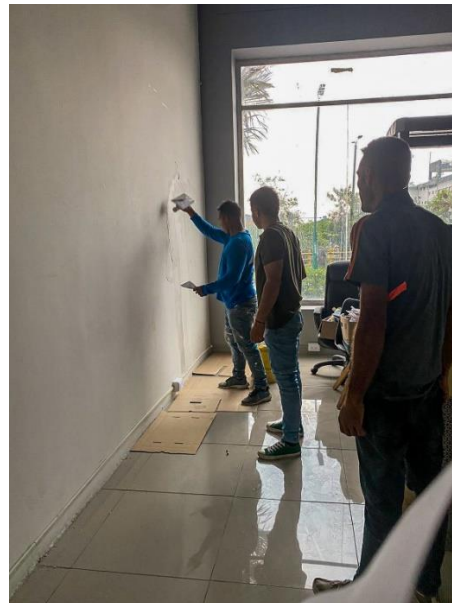
Figura 8 Proceso: estuco en las paredes
