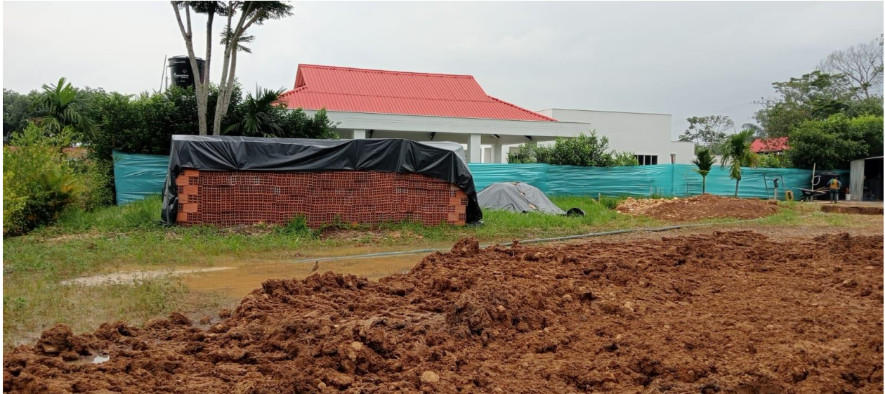
Figura 45 Proceso relleno: vista La Maria.
