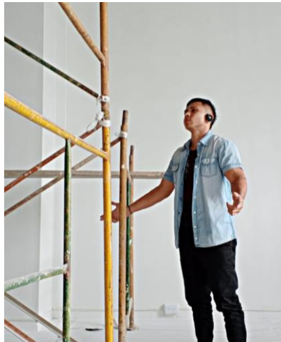
Figura 9 Instalacion de andamios.
