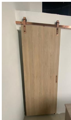
Figura 41 Instalacion de puertas corredizas
