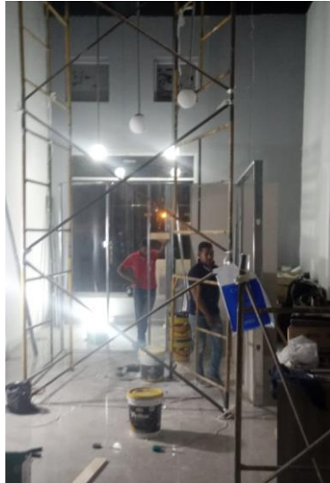
Figura 37 Instalacion de iluminarias – oficina de abogados.
