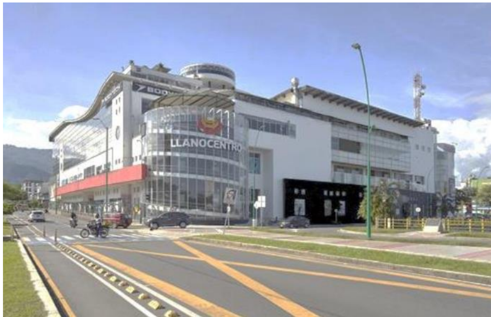
Figura 1 Ubicación COARCO S.A.S.
