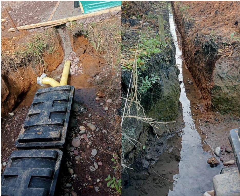
Figura 56 Instalación de tubos de desagüe
