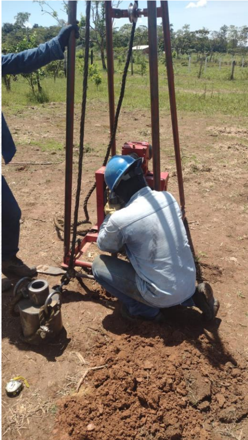
Ilustración 2. Extracción de residuos
