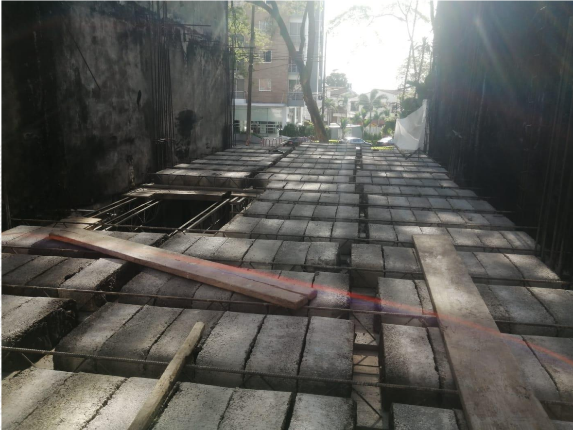
Figura 37 : Obra Barrio el Buque Placa entre piso (losa maciza)
