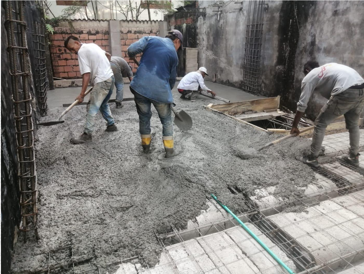
Figura 39 : Obra Barrio el Buque.- Fundición placa ente piso
