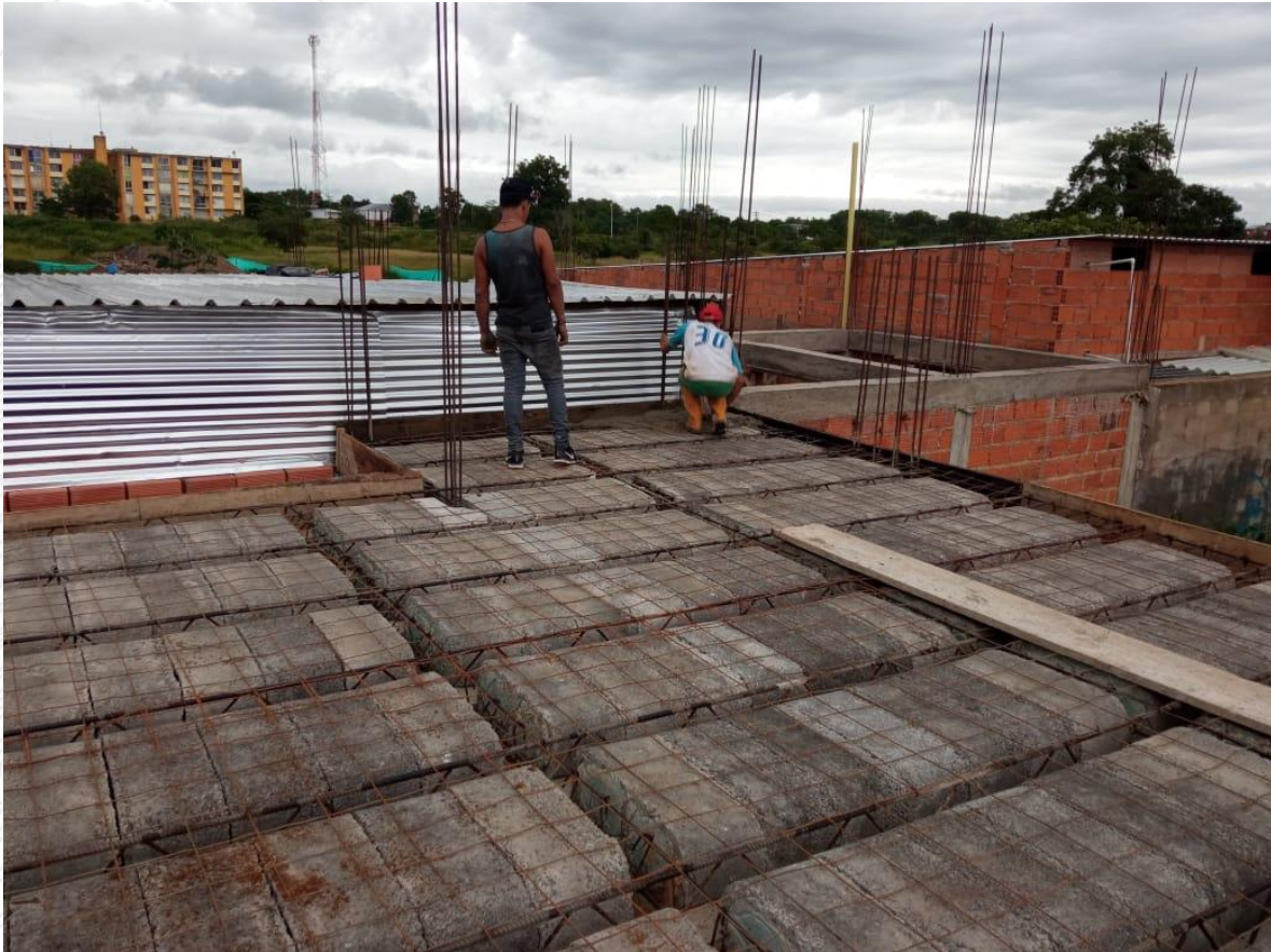
Figura 27: Obra municipio Puerto Gaítan – Placa entrepiso (losa maciza)
