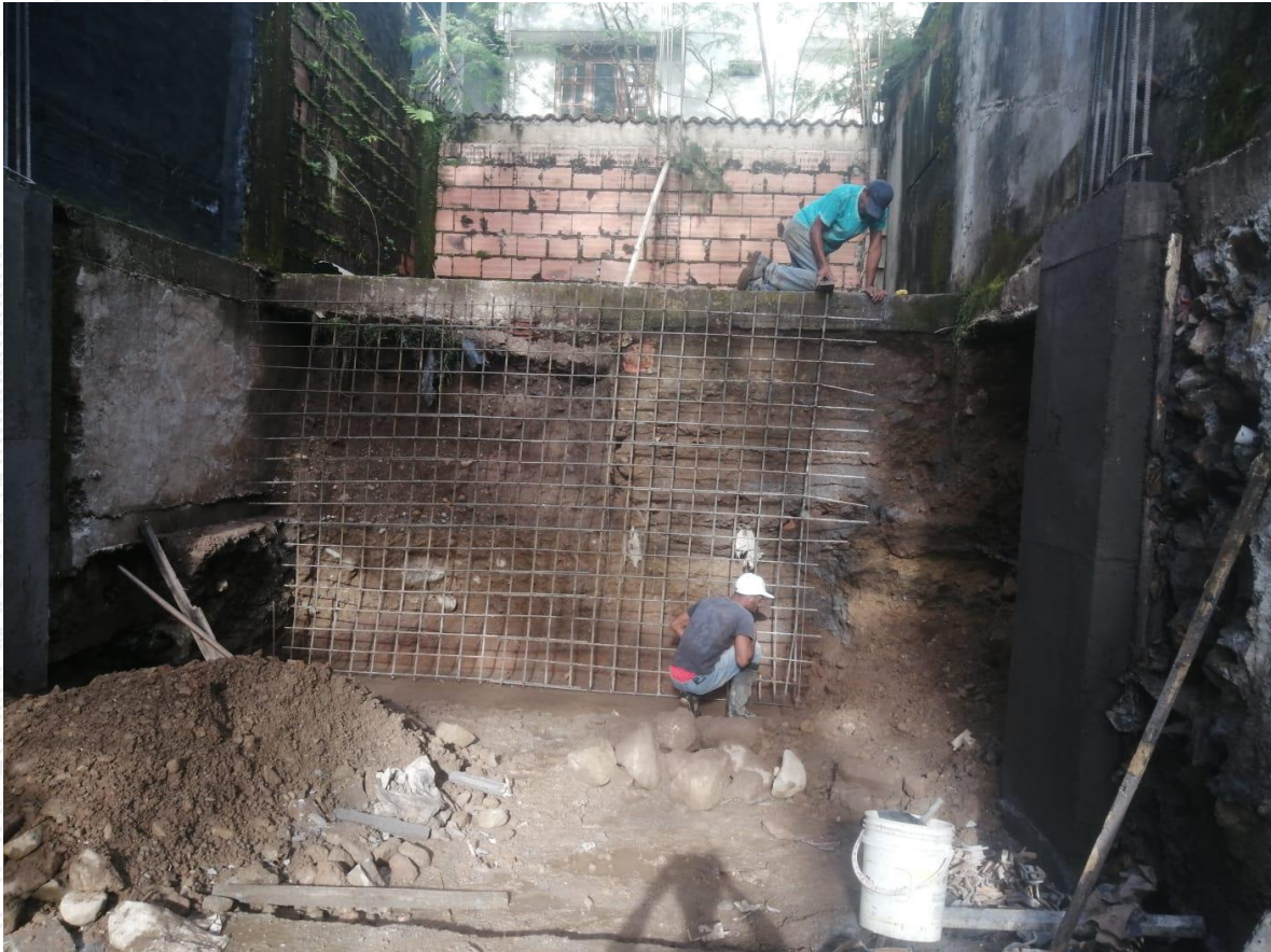
Figura 32 : Obra Barrio el Buque- Ubicación parilla para muro de contención
