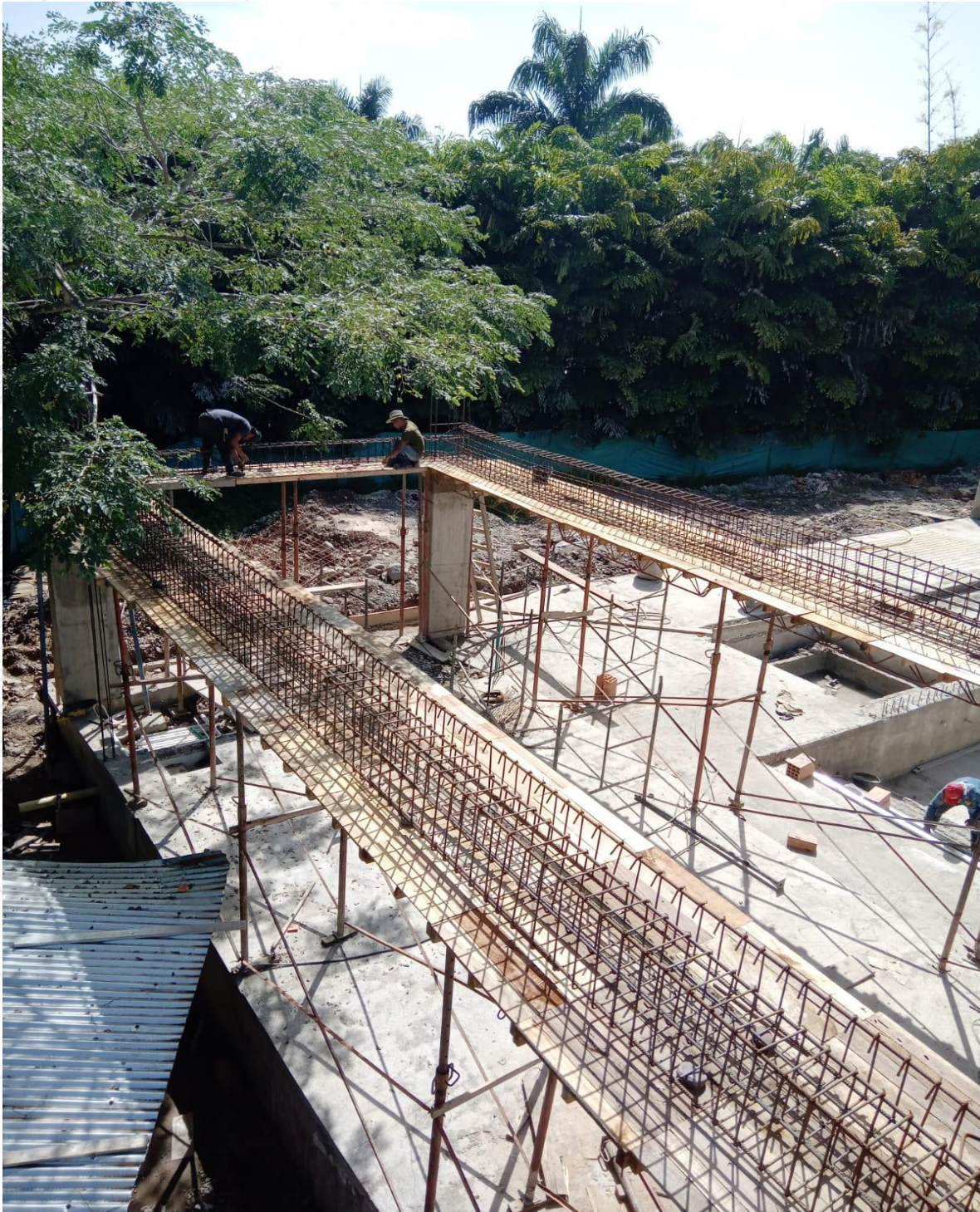
Figura 21:Obra casa campestre condominio la primavera- Vigas areas para cubierta zona social
