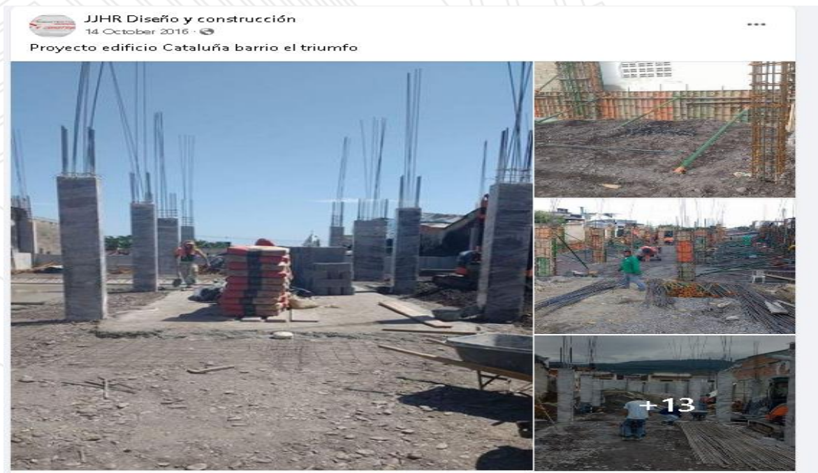
Figura 8: Construcción Edificio Residencial Barrio el Triunfo
