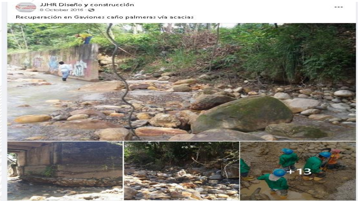
Figura 7: Construcción Obas de mitigación de Riesgos (Gaviones) sobre Caño palmeras Vía Acacias
