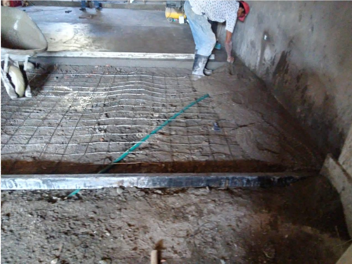
Figura 30 : Obra barrio la Florida Villavicencio – Placa de piso para bodega industrial
