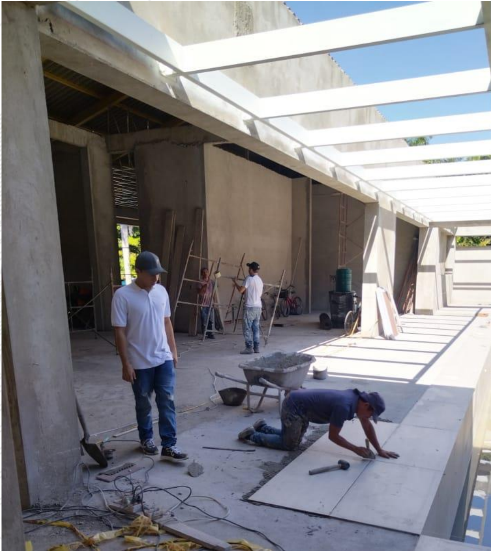
Figura 16-17-18 : Supervisión Instalación Enchape Piscina y Cielorraso en Drywall
