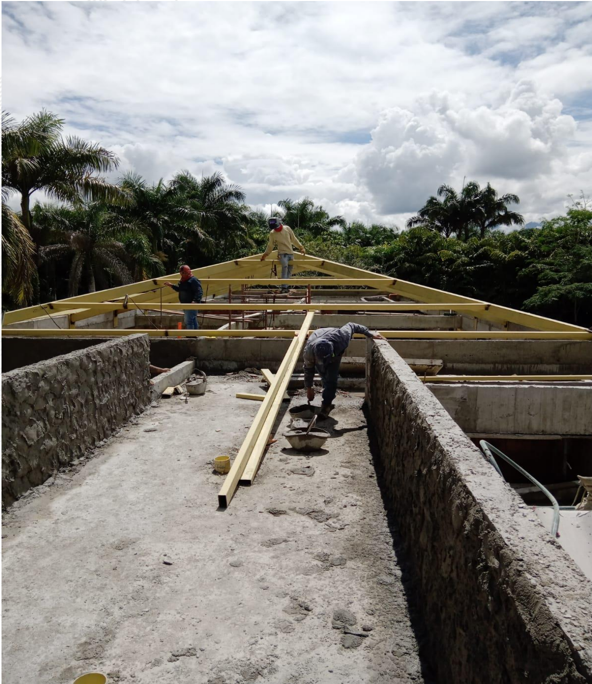
Figura 22 : Obra casa campestre condominio la primavera- Estructura Cubierta y pañete cubierta para impermeabilización
