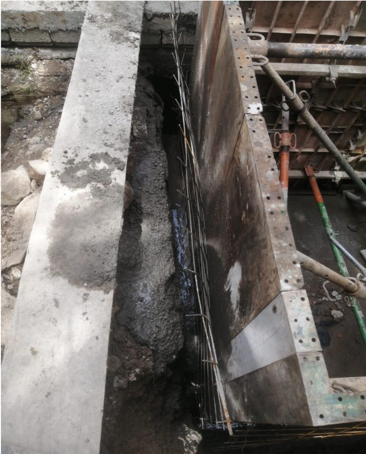
Figura 34 : Obra Barrio el Buque- Fundición muro de contención
