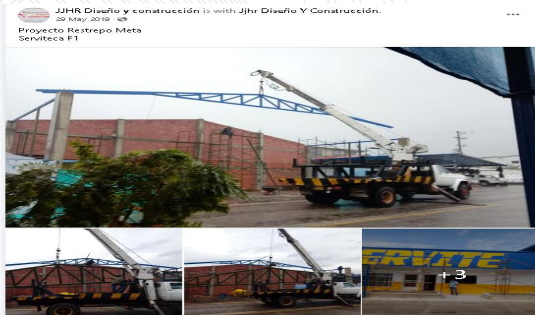
Figura 12: Construcción Serviteca Municipio Restrepo Meta
