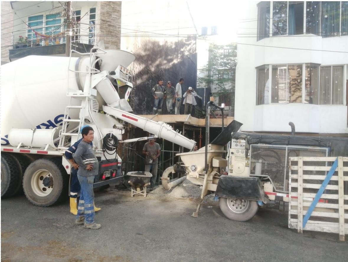
Figura 38: Obra Barrio el Buque- Proceso de transporte del concreto con mixer y bomba para distribuirlo en el area de la placa
