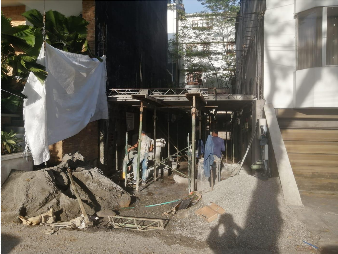
Figura 36 : Obra barrio el buque: Armado losa entre piso losa maciza
