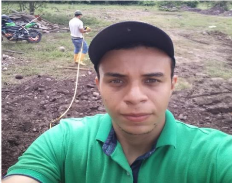
Figura 18-19-20: Replanteo de Lote para Cimentación de Vivienda Campestre
