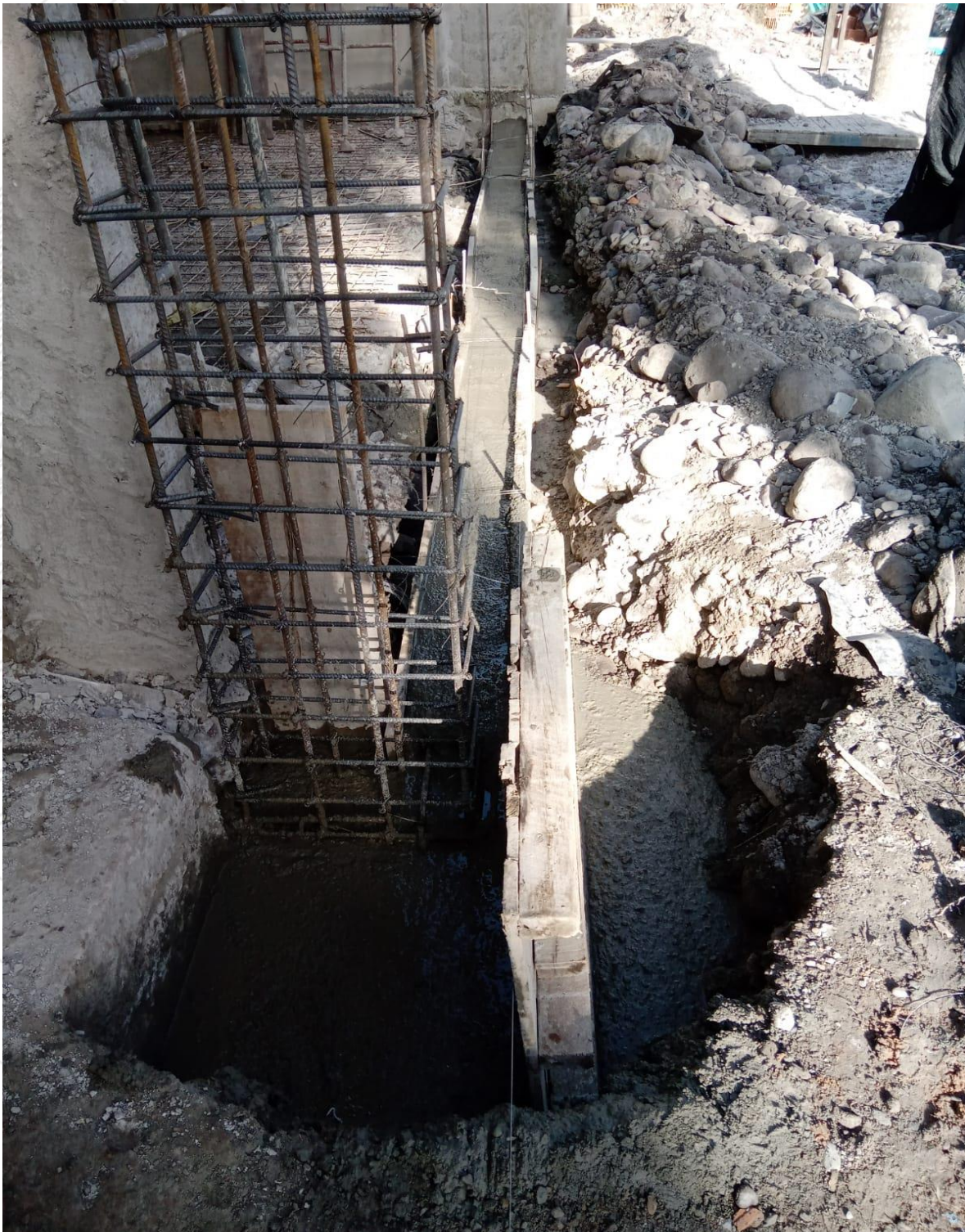
Figura 24 : Obra casa campestre condominio la primavera- Viga y columnas parte frontal de la propiedad
