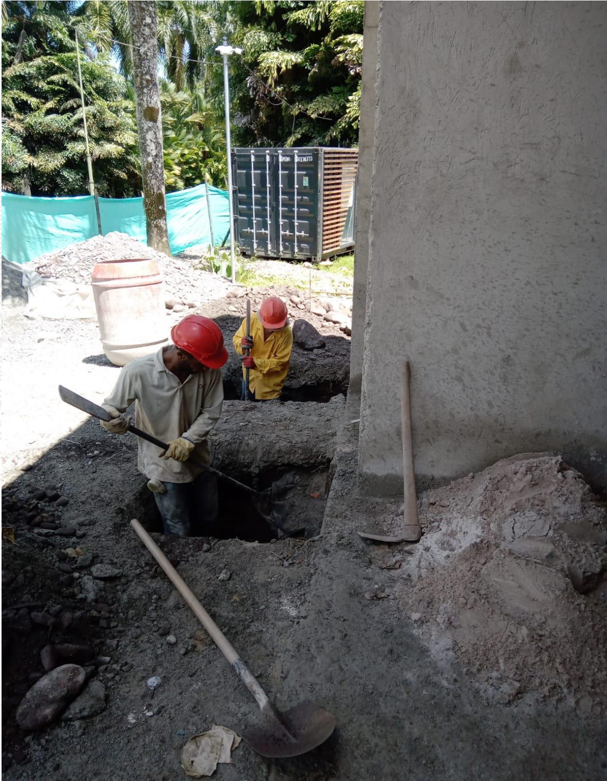
Figura 26: Obra casa campestre condominio la primavera- Huecos para columnas
