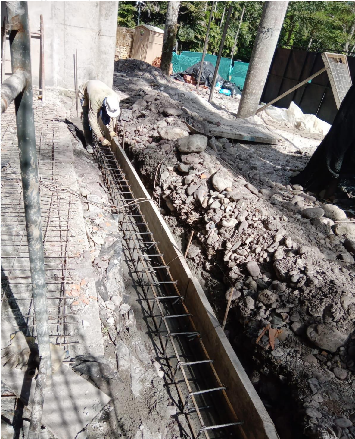
Figura 25 :Obra casa campestre condominio la primavera- Viga parte frontal de la propiedad
