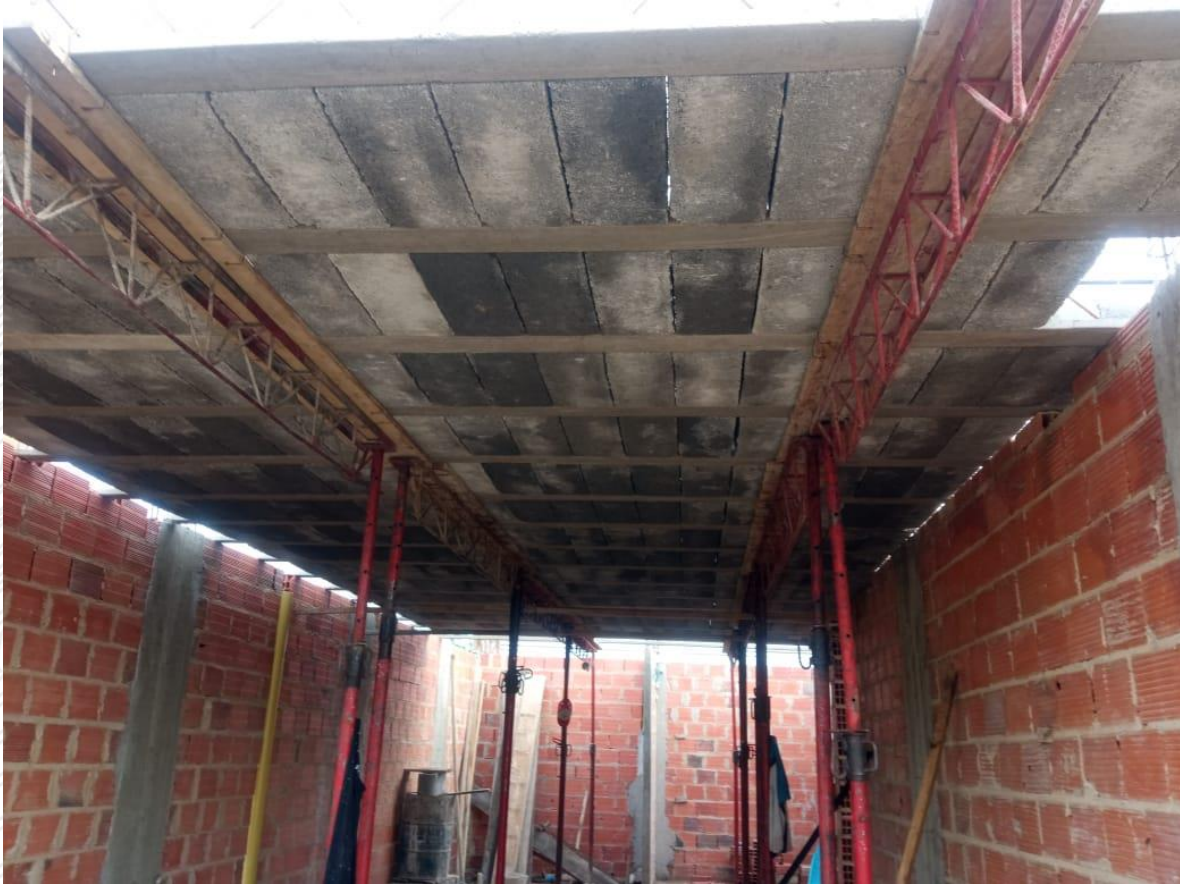
Figura 28 : Obra municipio Puerto Gaítan – Cerchas soporte de la Placa entrepiso (losa maciza)
