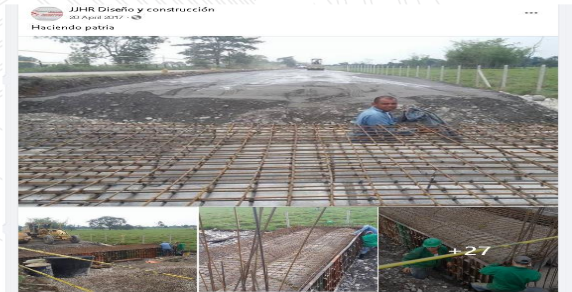
Figura 10: Construcción box culvert proyecto vial Corredor Ecológico
