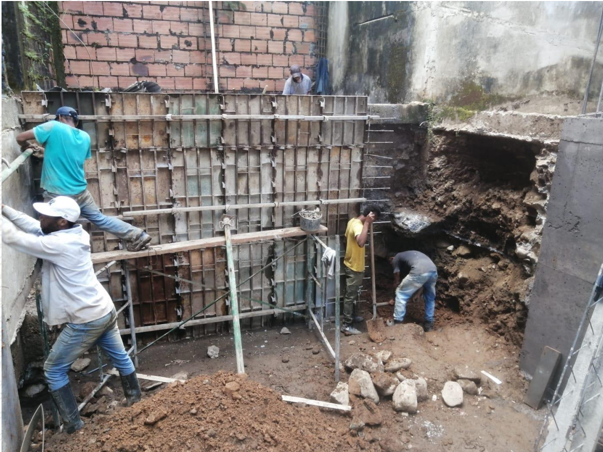
Figura 33 : Obra Barrio el Buque- Formaleteo de muro de contención
