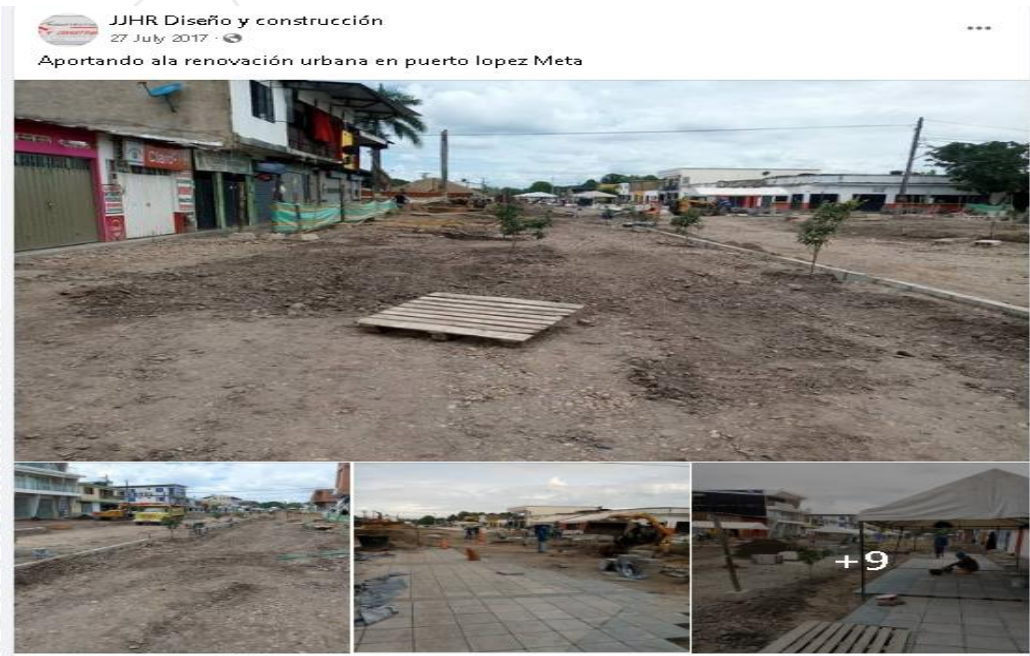
Figura 11: Construcción Urbanismo Municipio de Puerto López Meta
