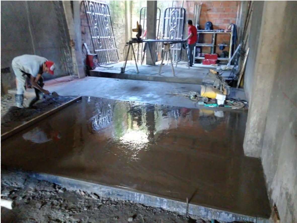
Figura 31 : Obra barrio la Florida Villavicencio – Placa de piso para bodega industrial
