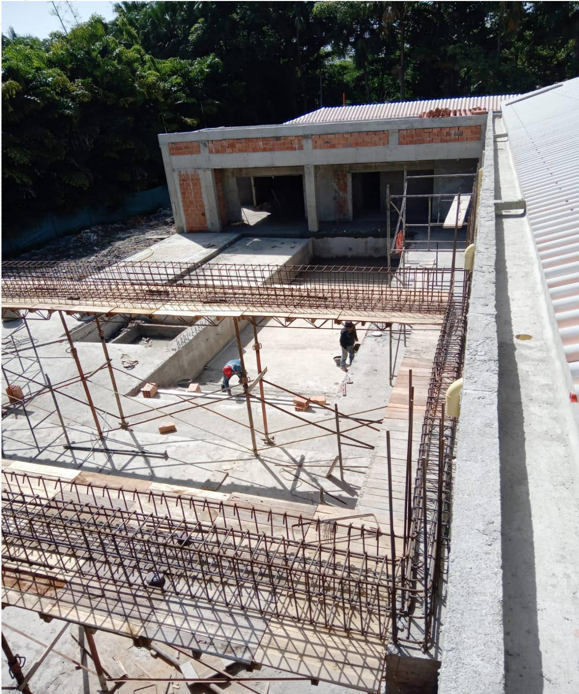
Figura 20 :Obra casa campestre condominio la primavera- Vigas areas para cubierta zona social
