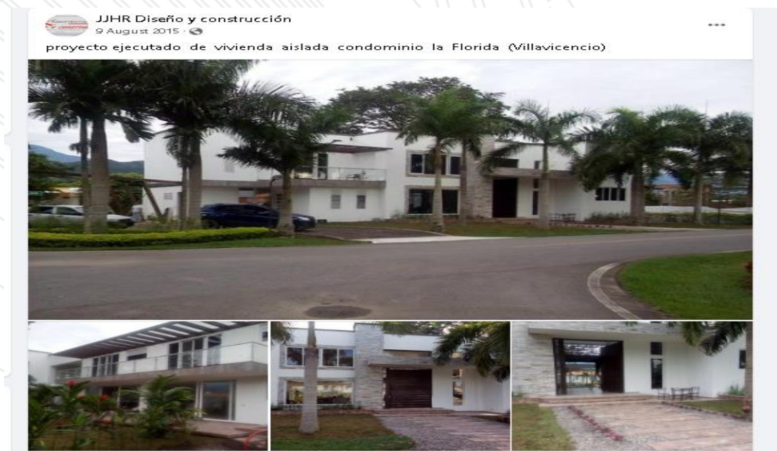
Figura 4: Construcción de Casas Campestres
