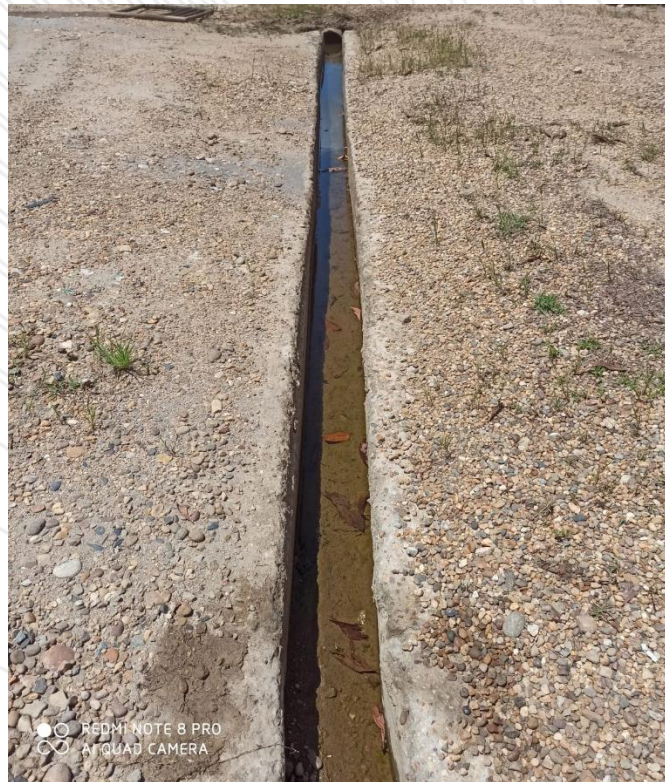
Ilustración 2 Construcción de canales y cunetas
