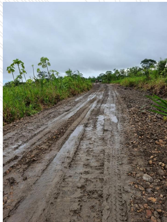
Ilustración 12 Riego con agua a la vía
