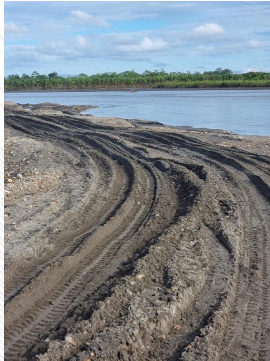
Ilustración 13 limpieza del área intervenida
