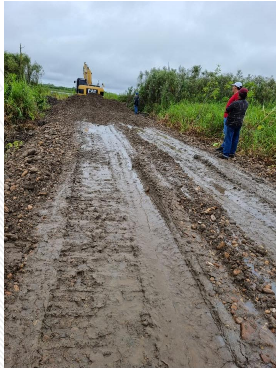
Ilustración 11 Mantenimiento a la vía
