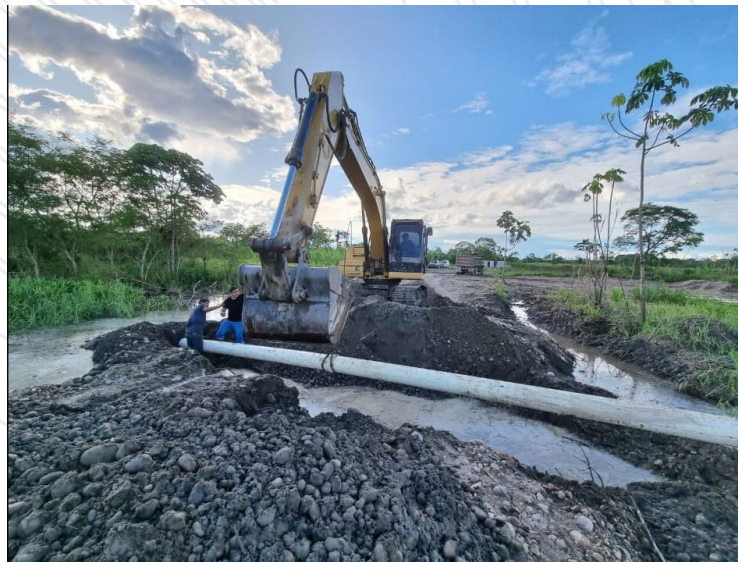
Ilustración 8 Construcción de la vía
