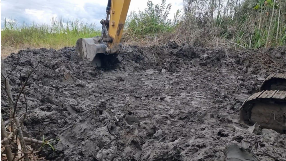
Ilustración 9 Construcción de la vía
