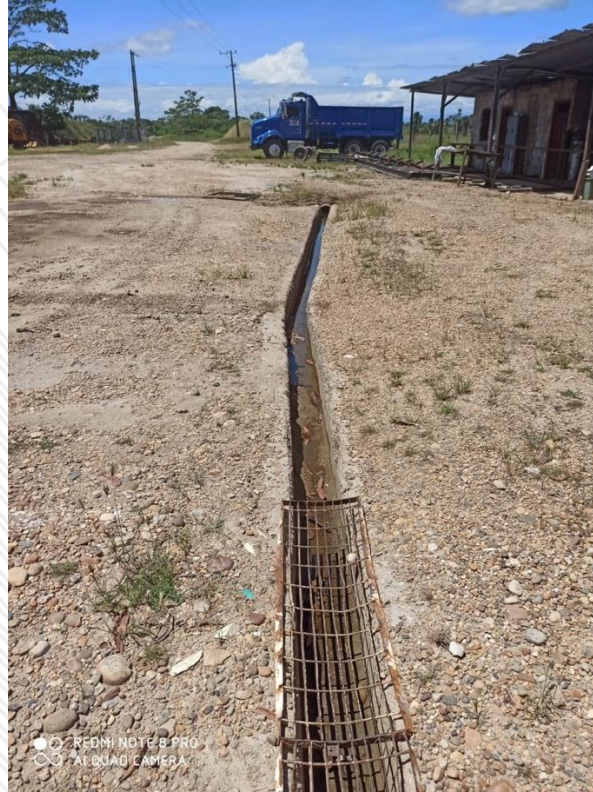
Ilustración 3 Construcción de canales y cunetas
