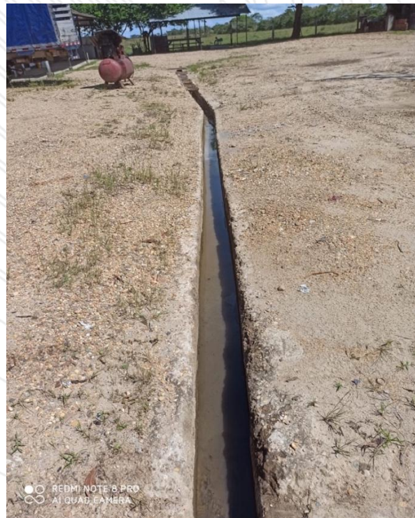
Ilustración 4 Mantenimiento de canales y cunetas
