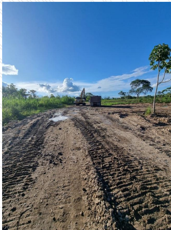
Ilustración 14 Retiro de la maquinaria cerca del margen del río
