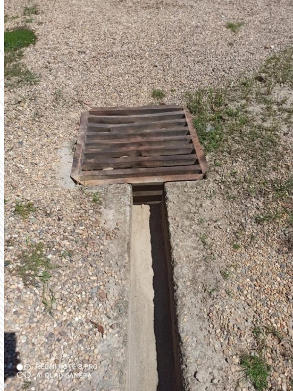
Ilustración 5 Mantenimiento de canales y cunetas
