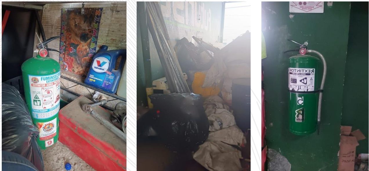
Figura 7. Inspección de extintores.
