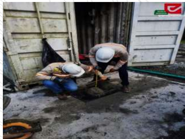
Verificando toma de asentamientos.
