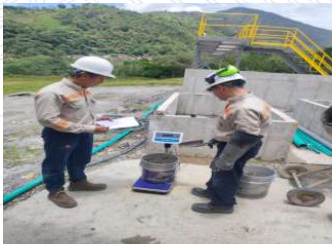
Verificando el peso de los agregados para las dosificaciones establecidas por los diseños.
