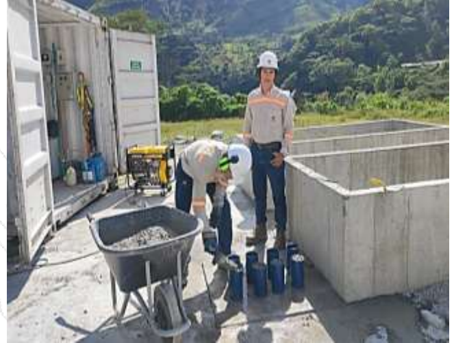
Realización Muestras de Concreto
