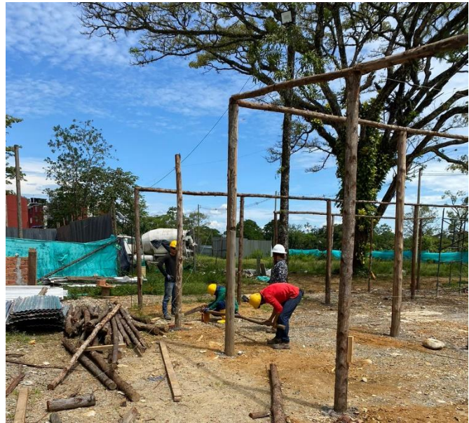
Supervisión montaje de campamento
